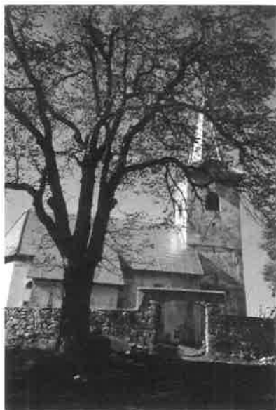
Pfarrkirche in Unterlag
