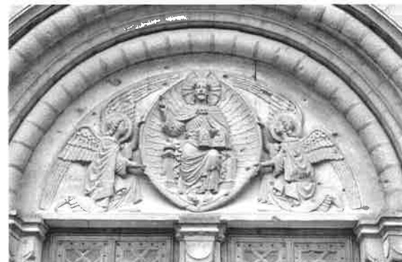
Bogenverzierungen über dem Eingangsportal
