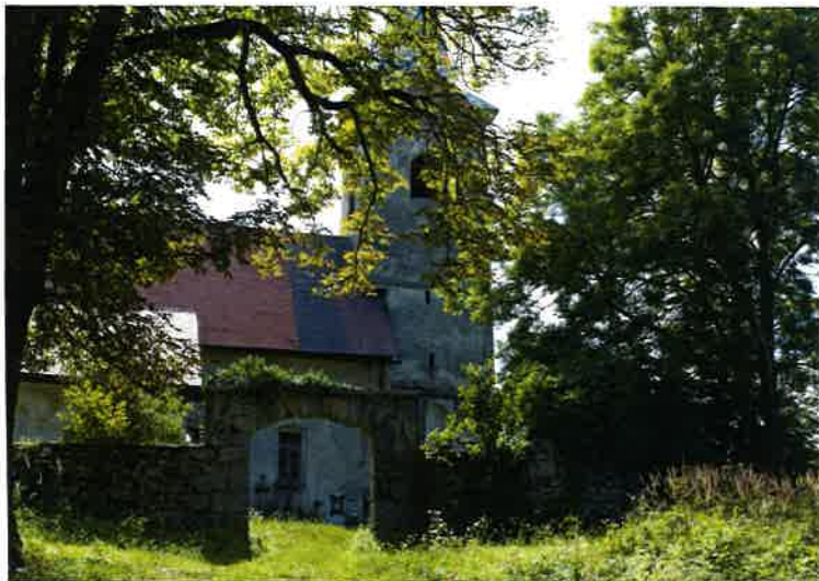
Unterlag, Zugang zur Kirche
