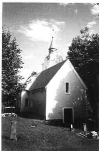
Renovierte Pfarrkirche St. Elias in Stockendorf
