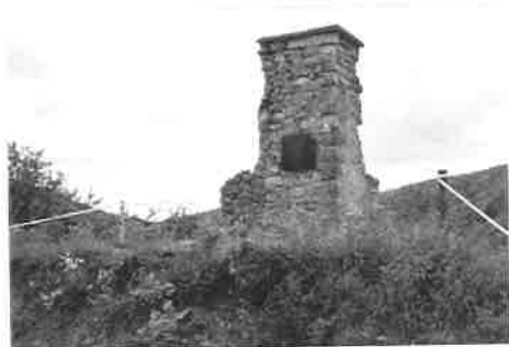
Ruine der ehemaligen Schule in Niedertiefenbach
