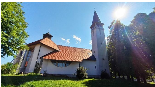
Slika 66: Novozgrajena cerkev v kraju Kočevska reka
