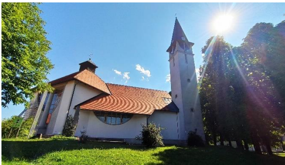
Foto 65: Die neu erbaute Kirche in Rieg
