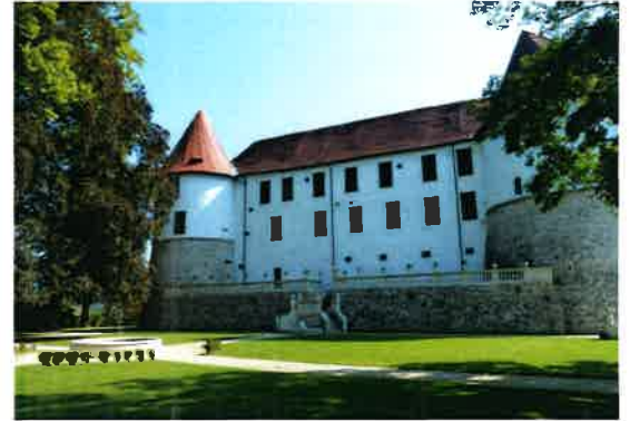
Schlossgarten nach der Renovierung
