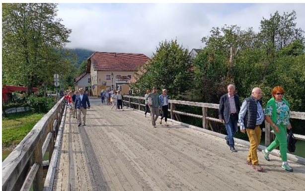
Foto 1: Landstraß - Südliche Holzbrücke
